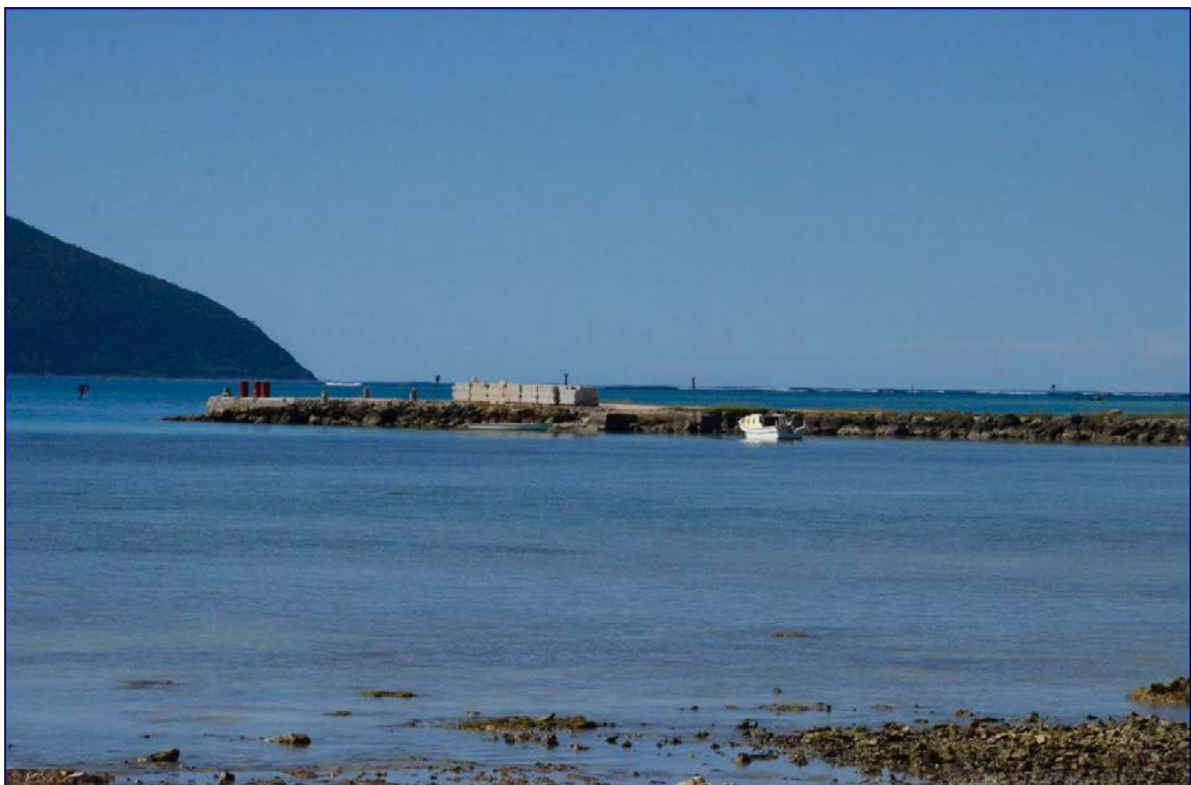
Figure 16: Pasivulangi Wharf, Niuatoputapu Harbour
